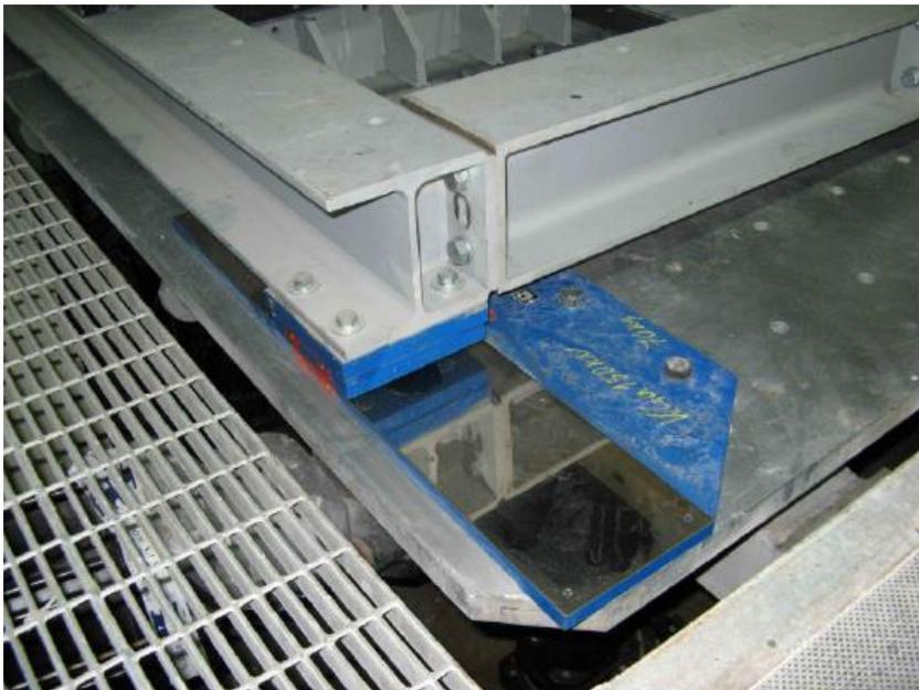
Abb. 11.22: Detail der ebenen PTFE Gleitlagerung
